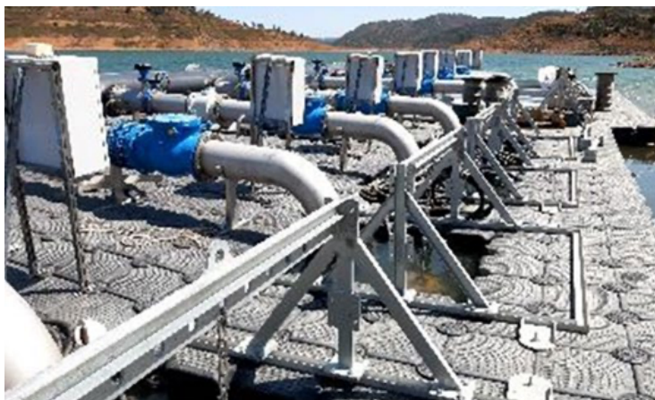
Figura 2. Exemplo de medida relativa à captação de volume morto em albufeira, neste caso a fotografia diz respeito a Odelouca
