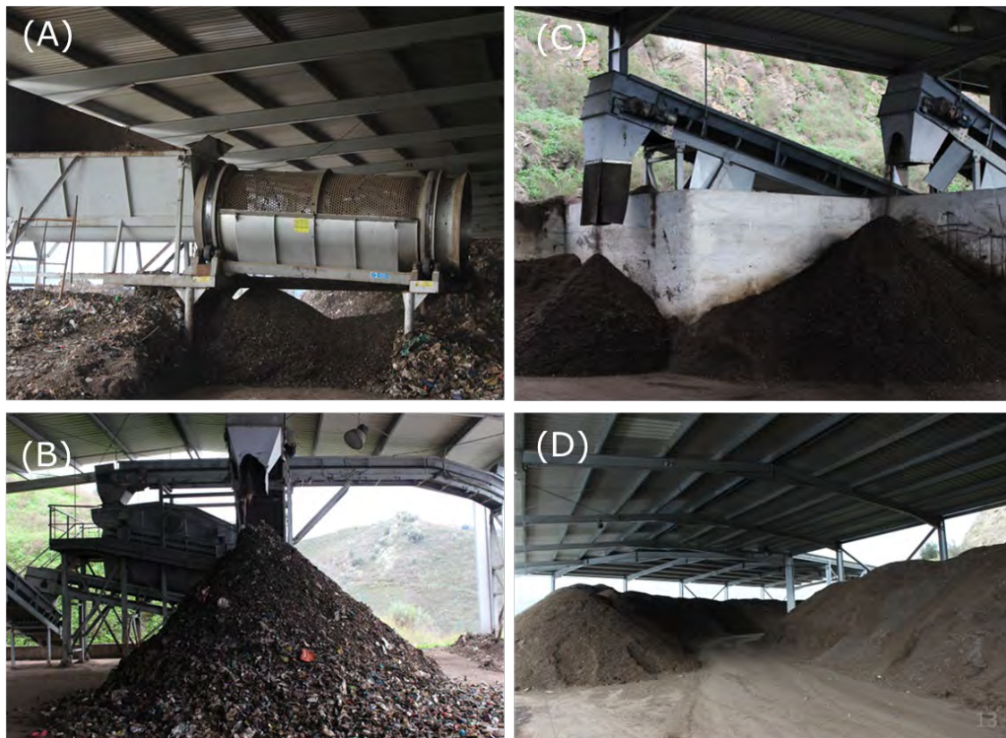
Figura 3. Afinação e crivagem do composto: (A) Trommel; (B) Crivo; (C) Mesa densimétrica; (D) Armazenamento
