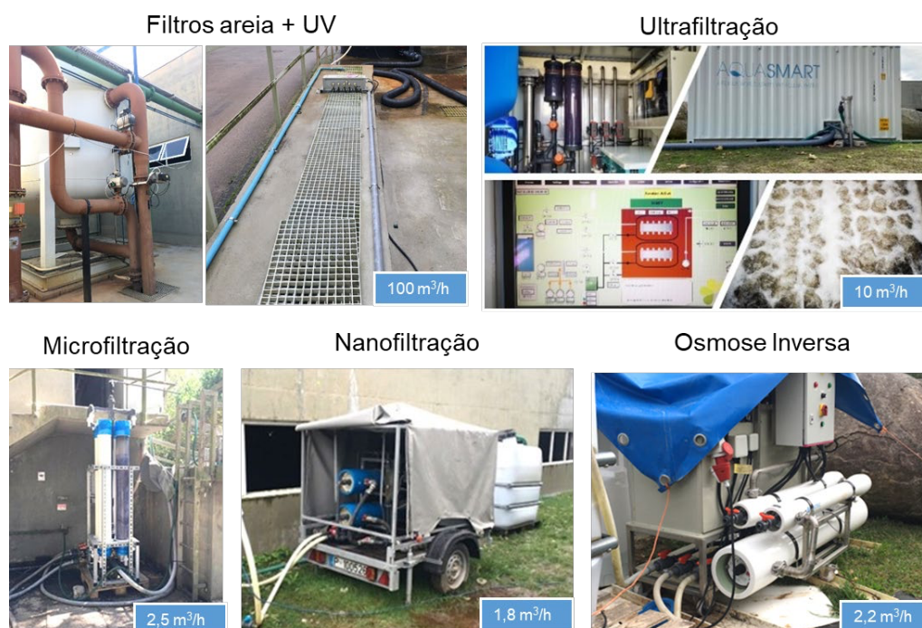
Figura 1. Imagens das tecnologias terciárias testadas na ETAR para produção de ApR.
