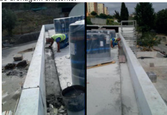
Figura 10. Execução das caleiras na cobertura
