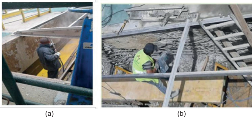
Figura 12. Trabalhos de hidrodecapagem e picagem
