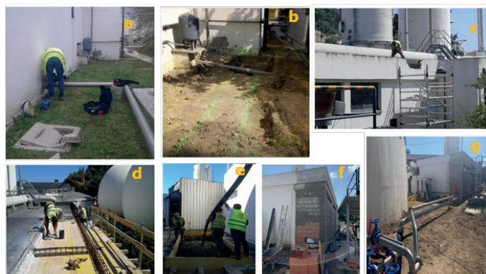
Figura 15. Sequência dos trabalhos de ampliação do edifício de espessamento e desidratação de lamas
