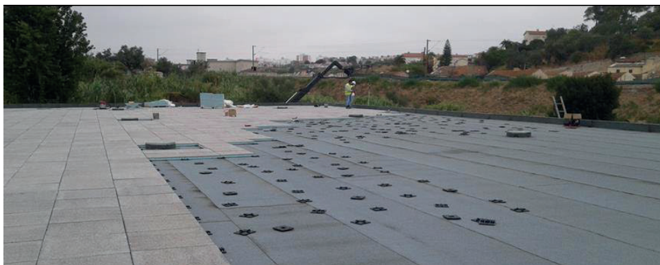
Figura 6. Colocação da membrana betuminosa na nova cobertura do edifício dos desarenadores e decantadores primários
