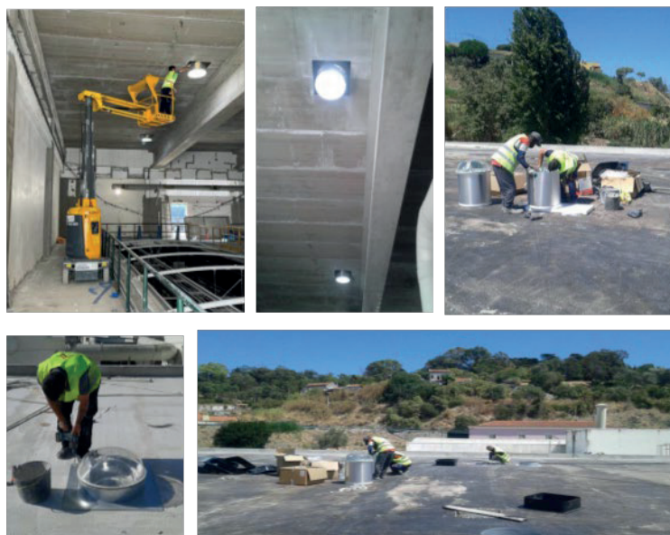
Figura 8. Instalação dos tubos solares
