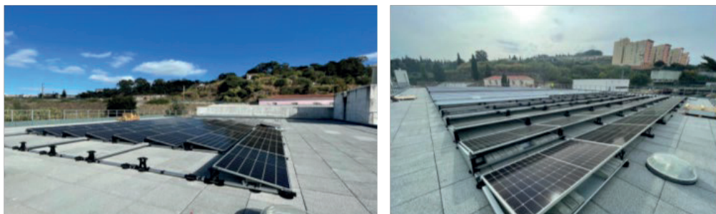
Figura 7. Instalação dos módulos fotovoltaicos
