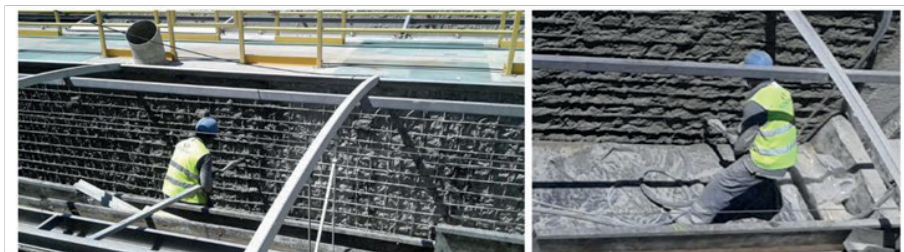
Figura 13. Reposição das armaduras e betonagem
