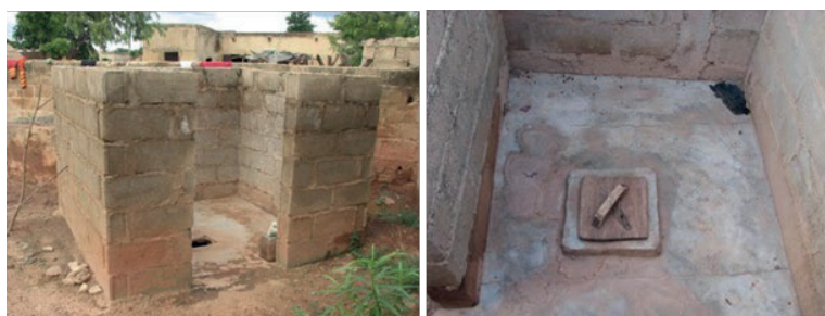
Figura 1. Imagens de latrinas tradicionais
